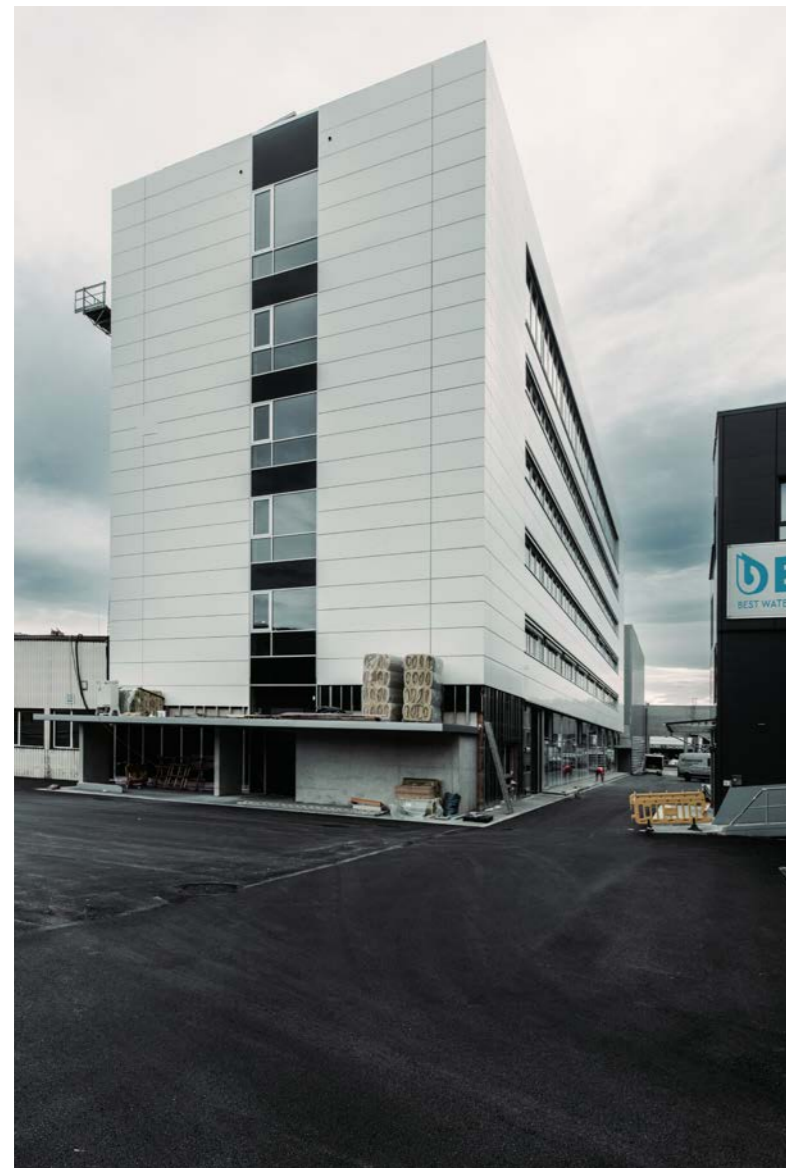
BWT BÜRO- & PRODUKTIONSGEBÄUDE MONDSEE 2020-2021
