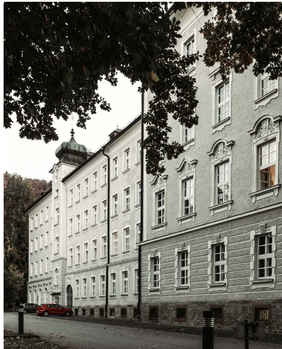
BORROMÄUM SCHULUMBAU, SALZBURG 2020-2021
