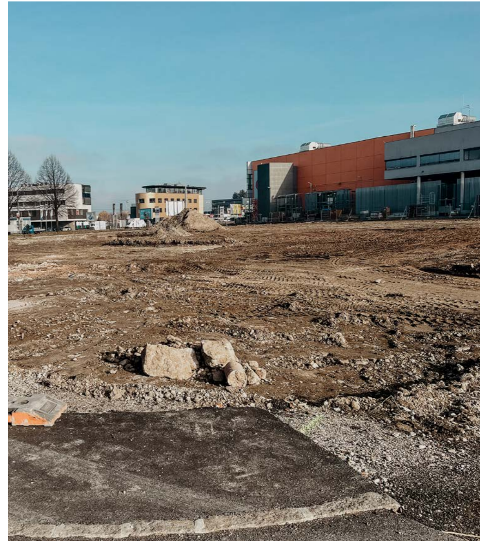
BV OBERSCHIEDER PARKDECK MIT WASCHANLAGE, MAXGLAN 2021-2022
