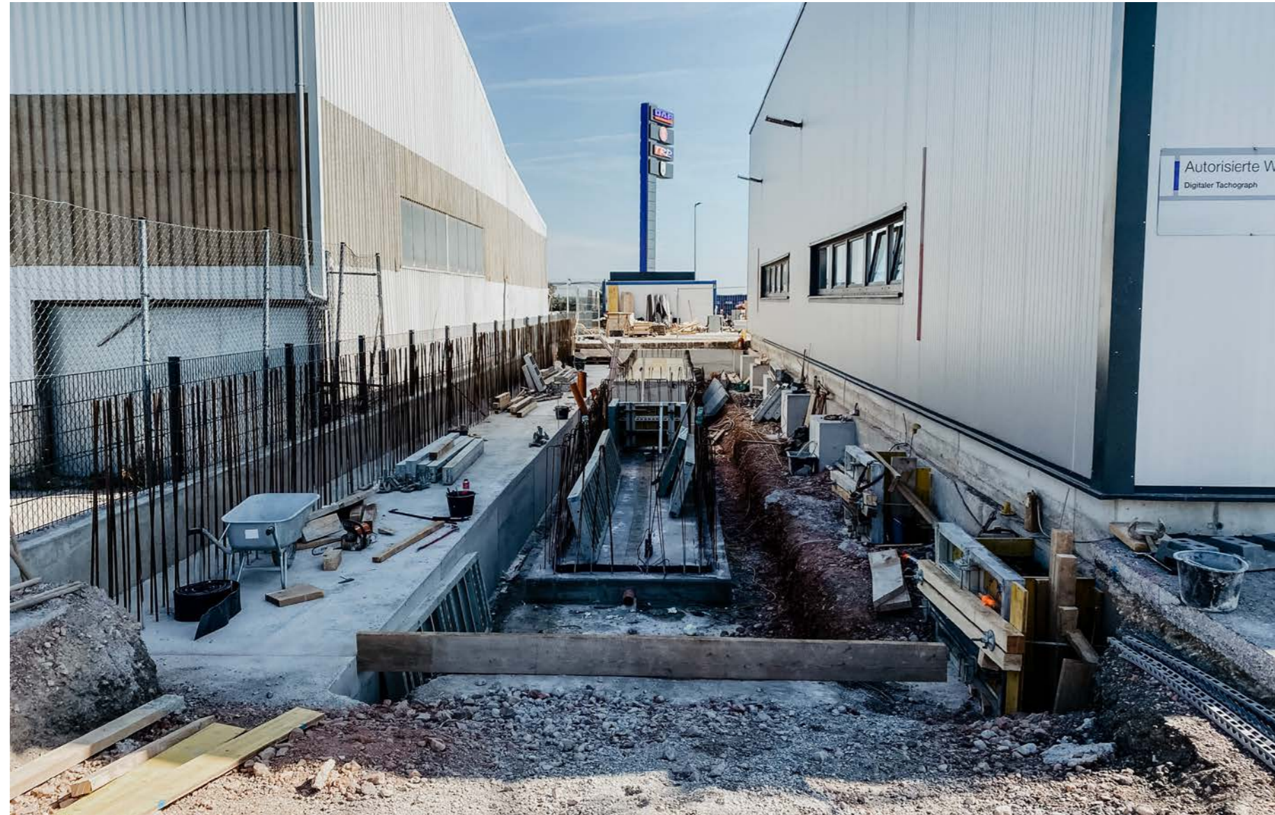
AUTOHAUS TSCHANN HIMBERG/WIEN, ANBAU LKW WERKSTATT & WASCHBOX 2021
