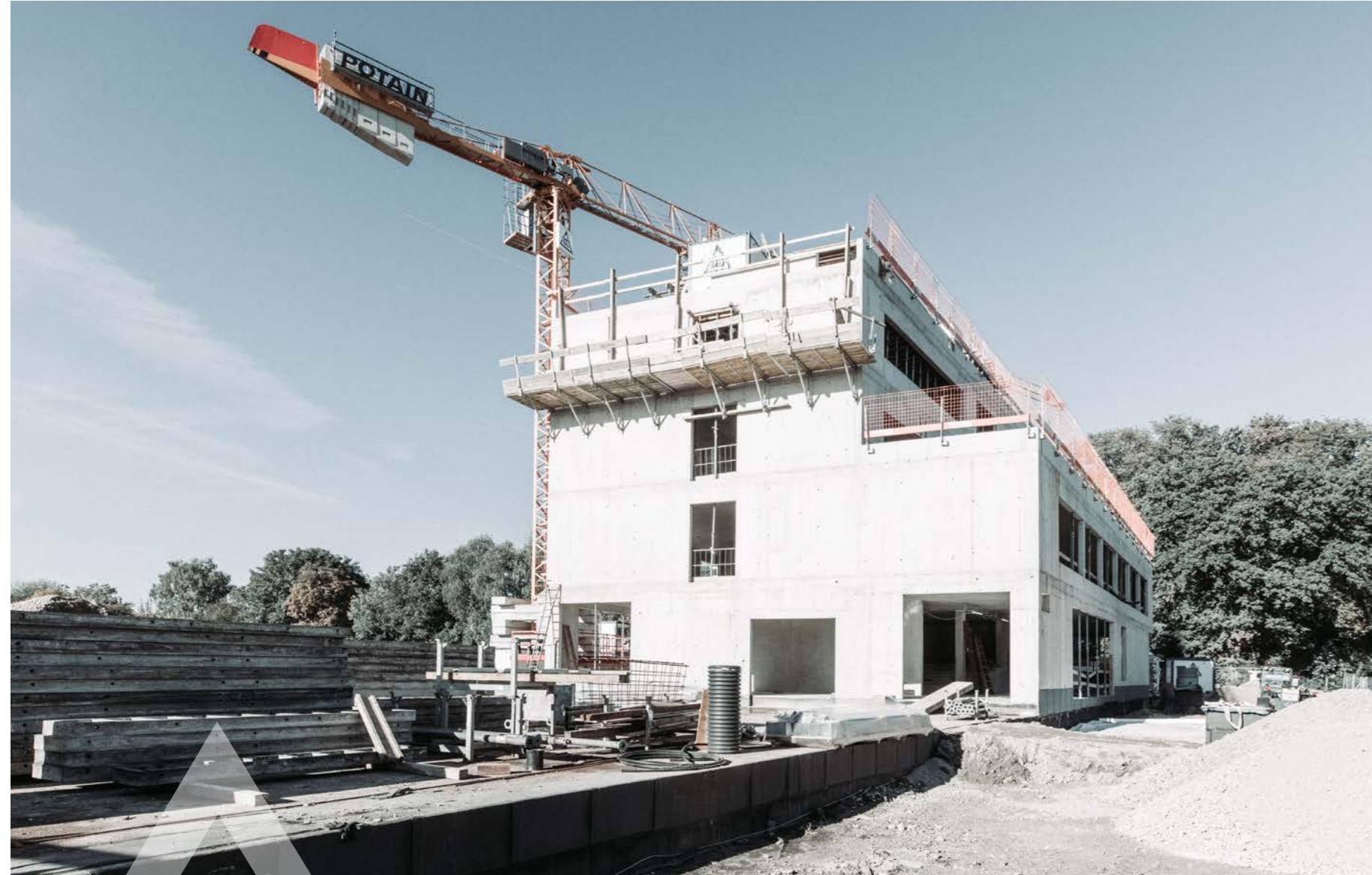
COPA DATA BÜROGEBÄUDE, KAROLINGERSTRASSE 2021-2022
