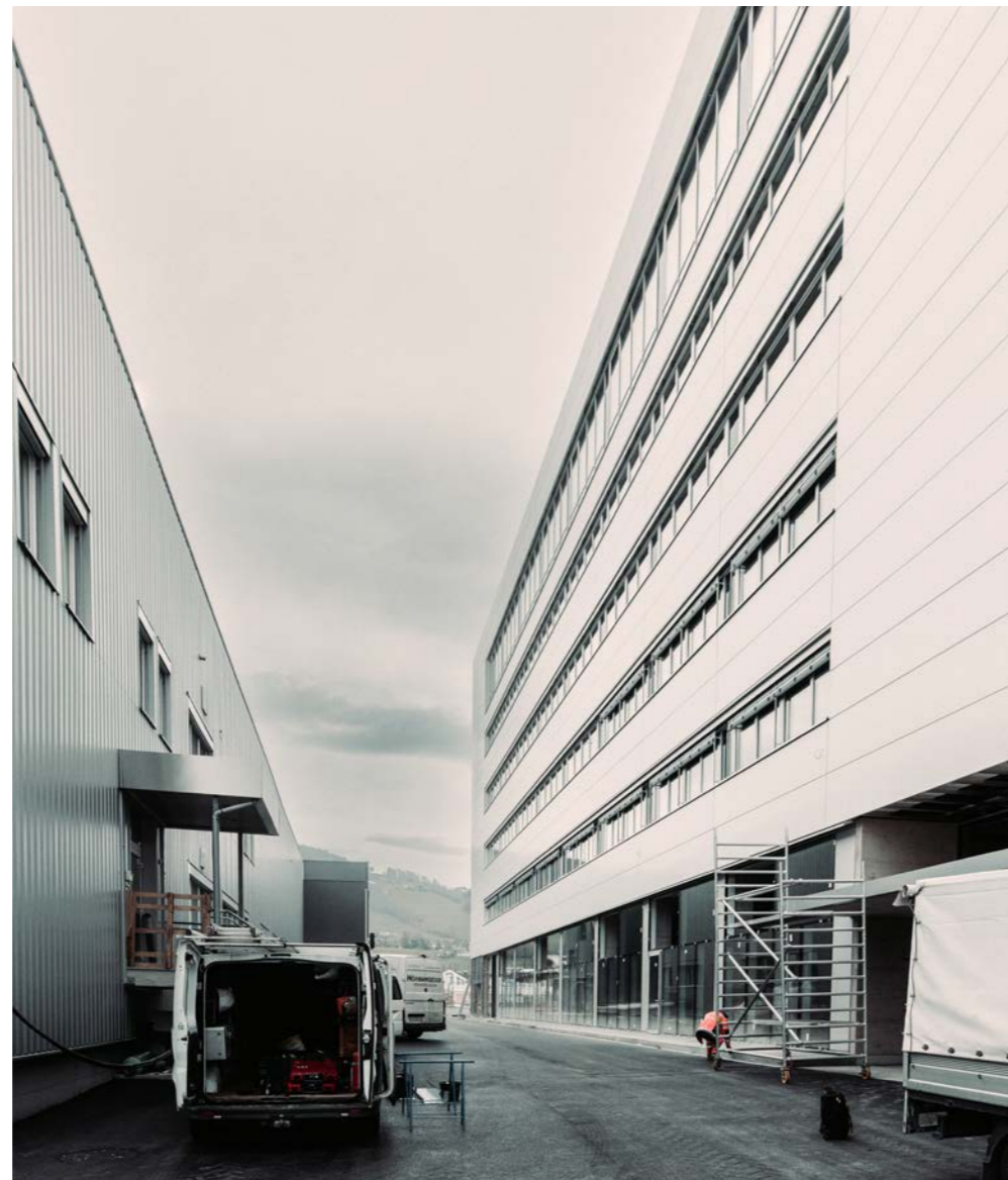
NEUBAU / TROCKENBAU / BAUMEISTER
