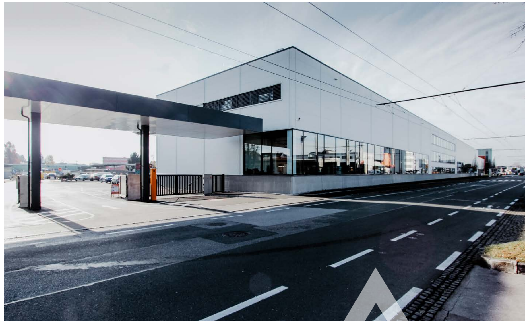
GROSSBAUSTELLE ARGE WIRTSCHAFTSHOF 2019-2021
