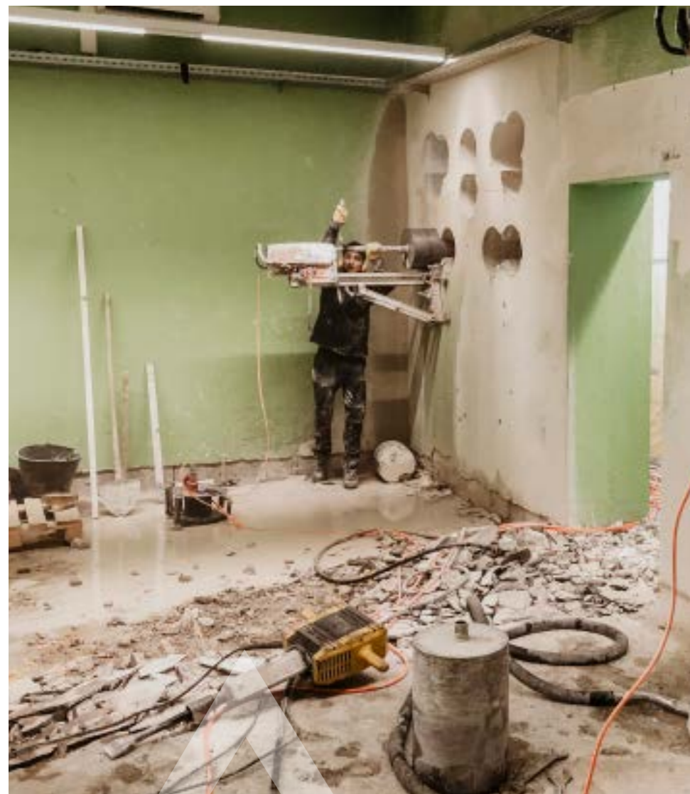
FRESSNAPF UMBAU ALPENSTRASSE 2021
