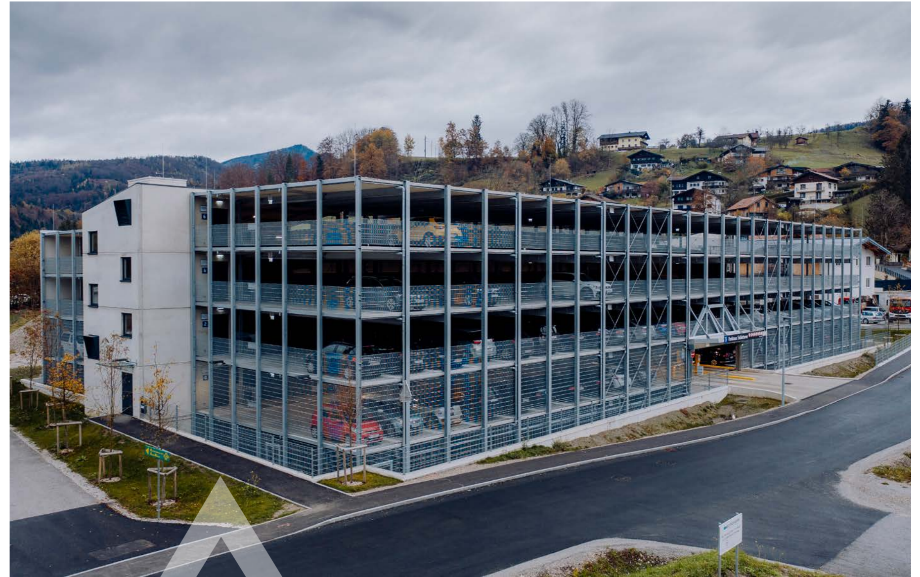
BAULEITER Bmstr. Ing. Matthias Töplitzer
