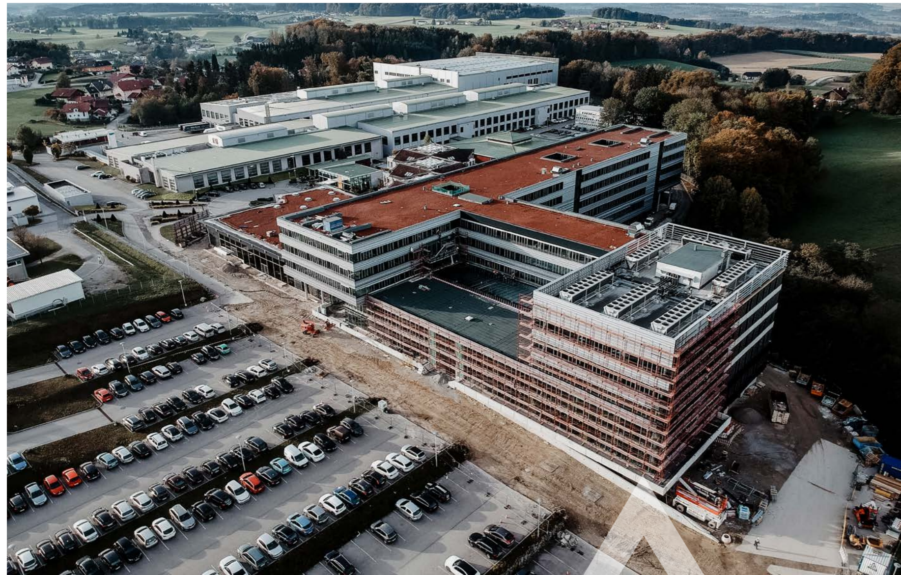
GROSSBAUSTELLE ARGE B&R, EGGELBERG / 2018-2020
