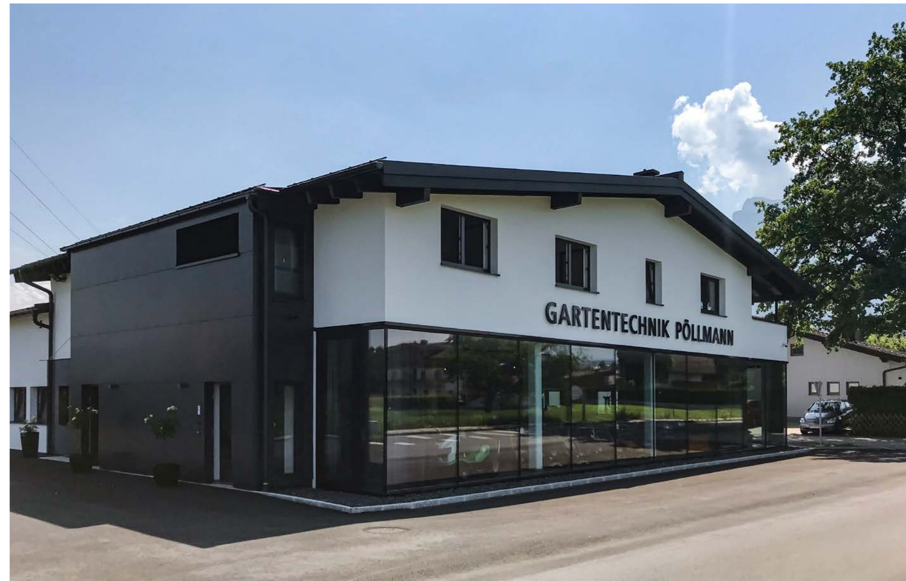
PÖLLMANN, WALS / 2019-2020 / NEUBAU BETRIEBSGEBÄUDE, GENERALUNTERNEHMERARBEITEN & TROCKENBAU
