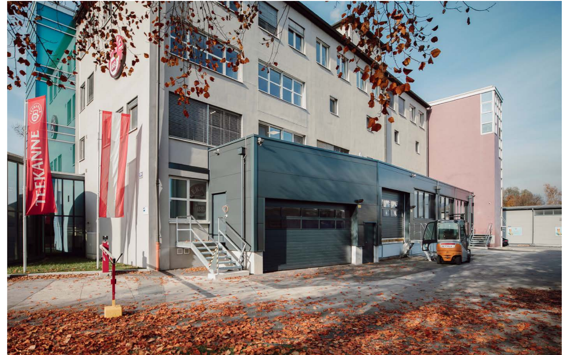
BAULEITER Bmstr. Ing. Matthias Töplitzer
