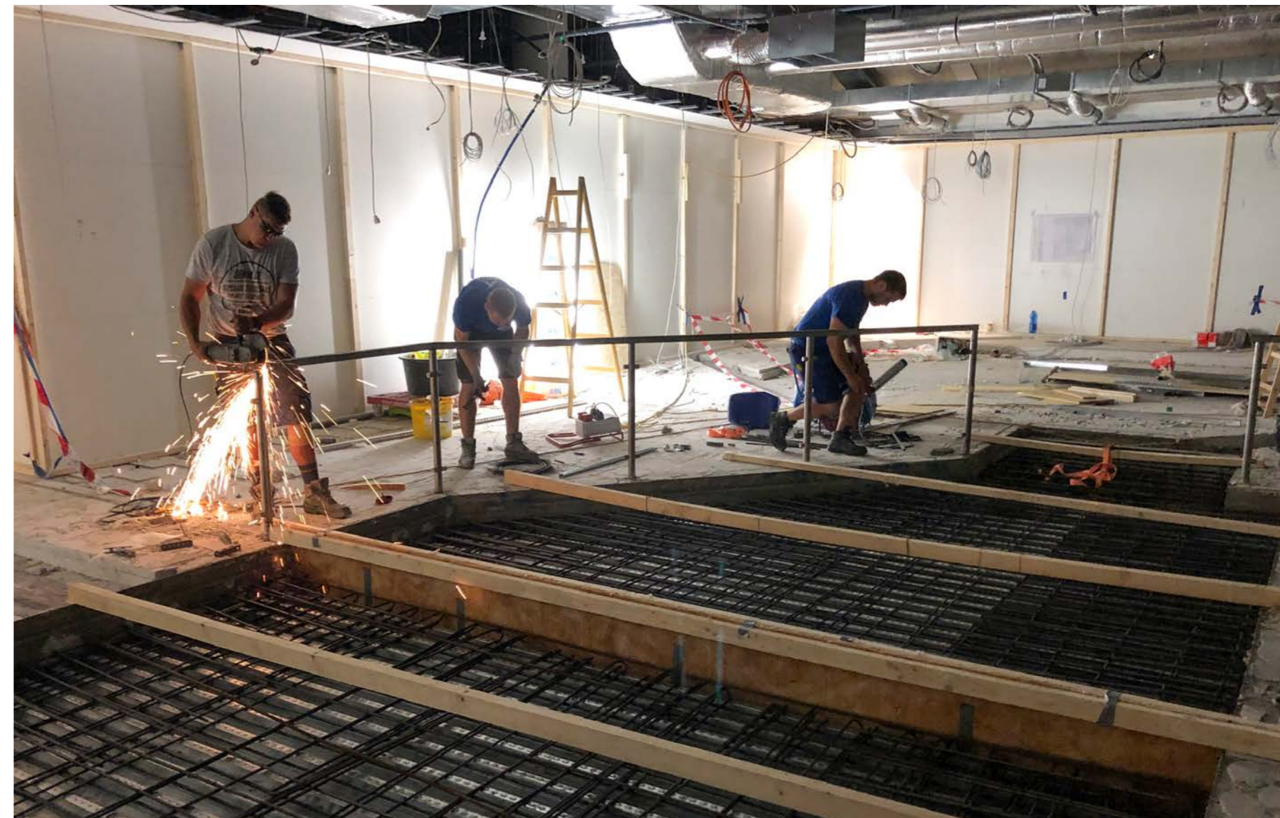
EUROPARK HERVIS/H&M, SALZBURG / 2020 BAUMEISTERARBEITEN & TROCKENBAU
