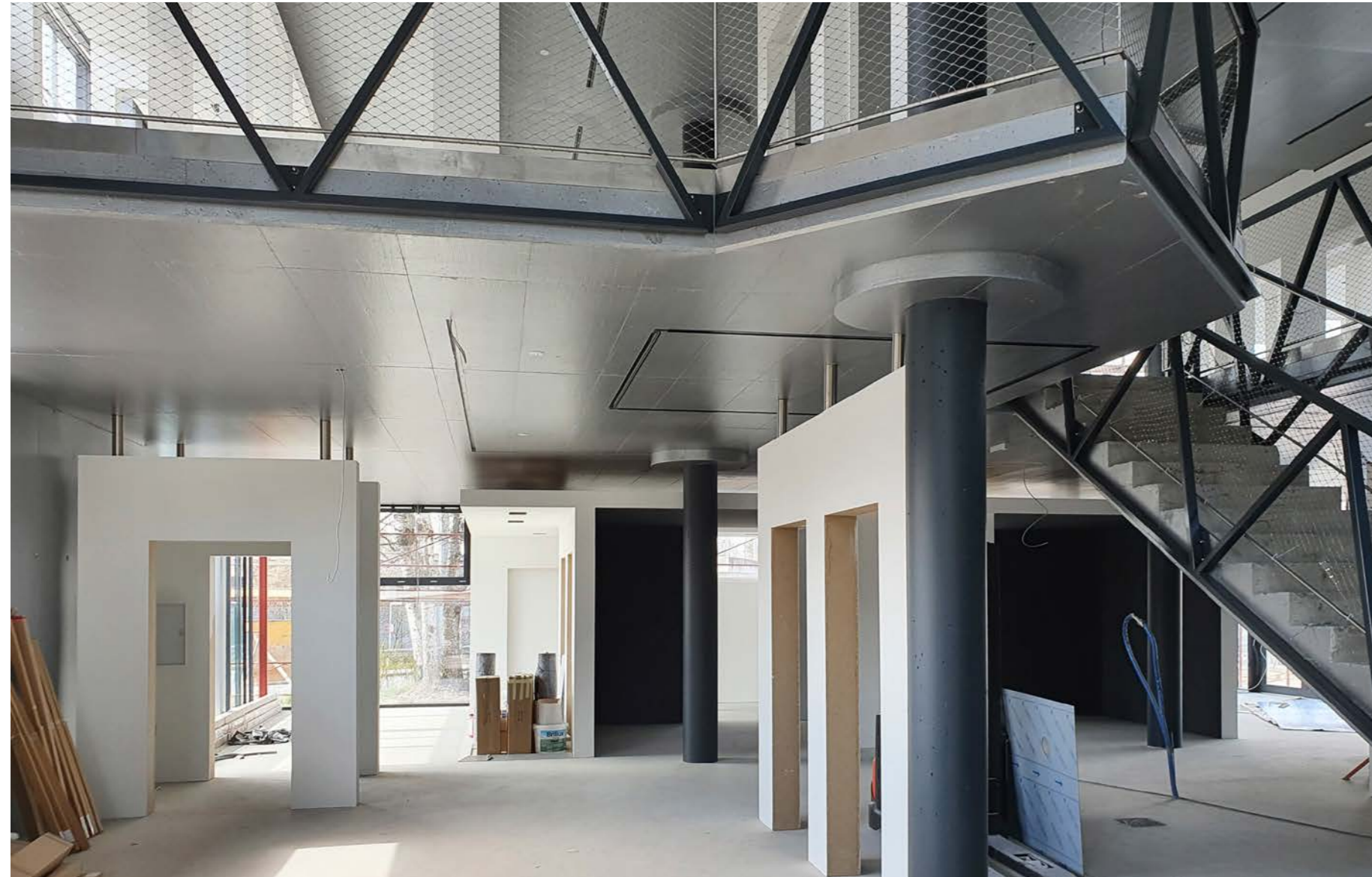
HANNAK BÜRO &amp; AUSSTELLUNGSGEBÄUDE / 2020
