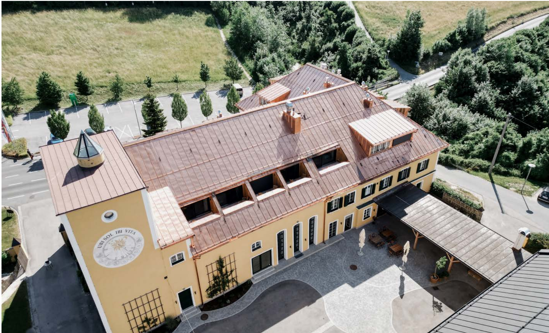
STIEGL, GÄSTEHAUS AUSBAU DACHGESCHOSS, WILDSHUT, 2022 – 2023
