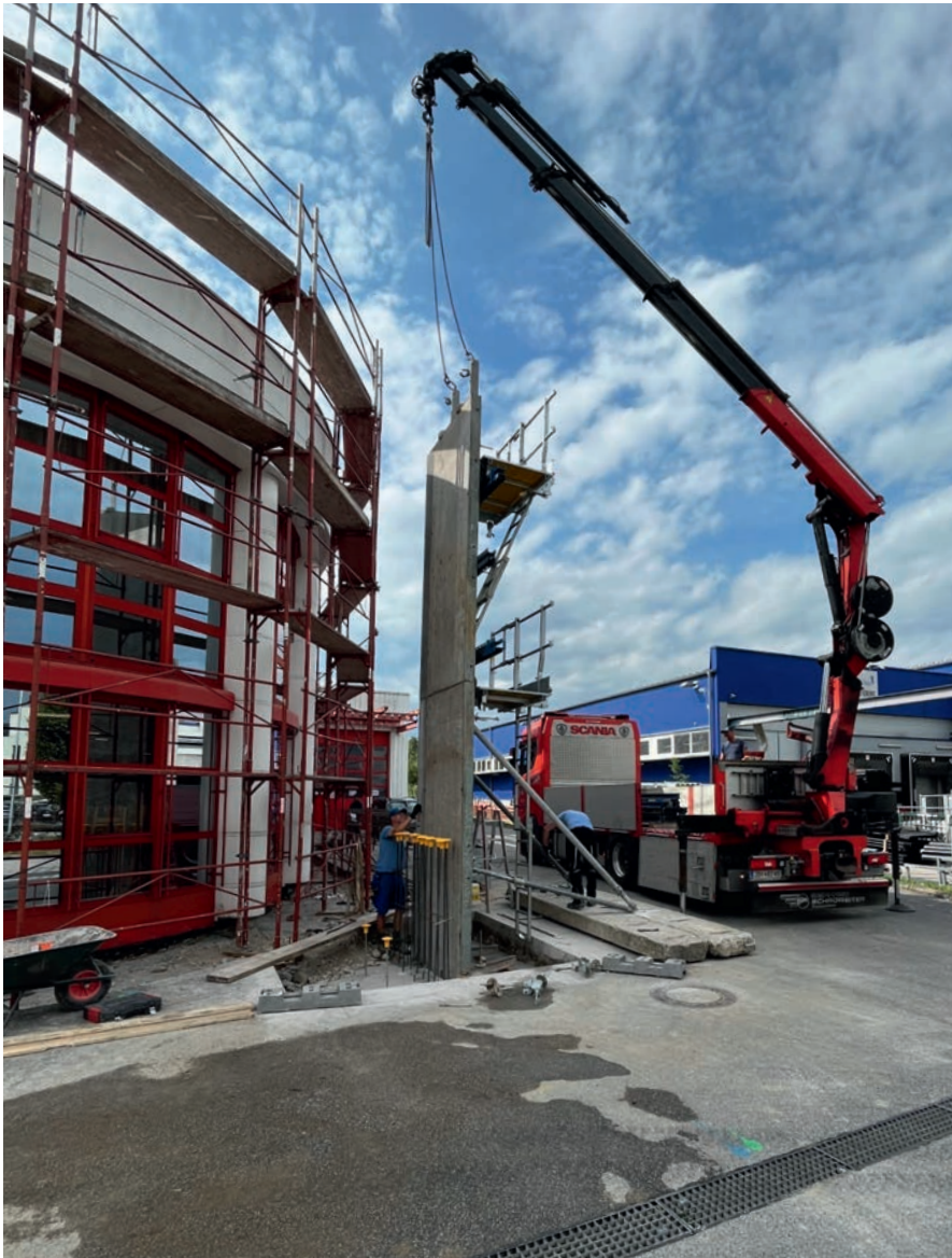
BAULEITER Bmstr. Ing. M. Töplitzer TECHNIKER Ing. A. Koller
