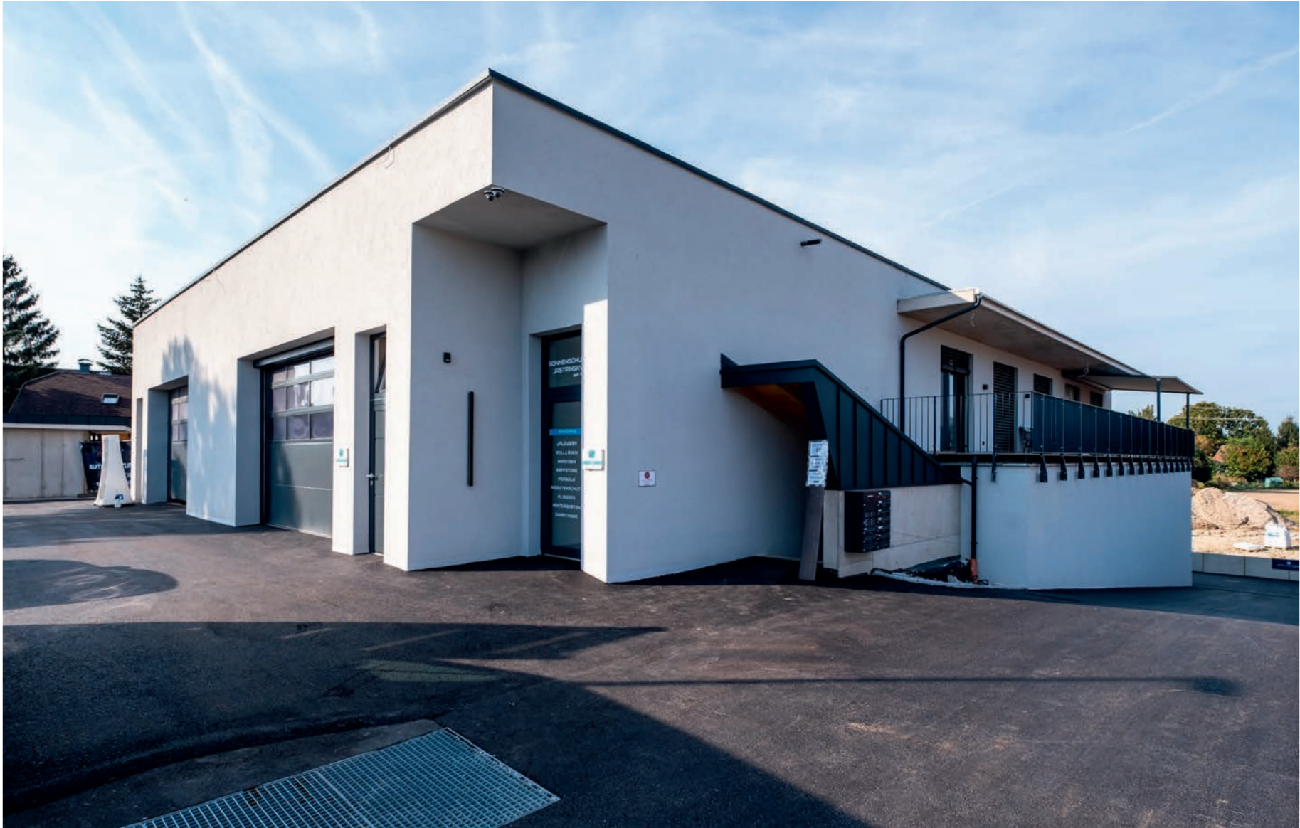
BETRIEBSGEBÄUDE SCHALL, SAALACHSTRASSE 90, SALZBURG, 2023 – 2024
