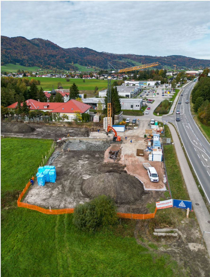
BAULEITER Bmstr. Ing. M. Töplitzer
