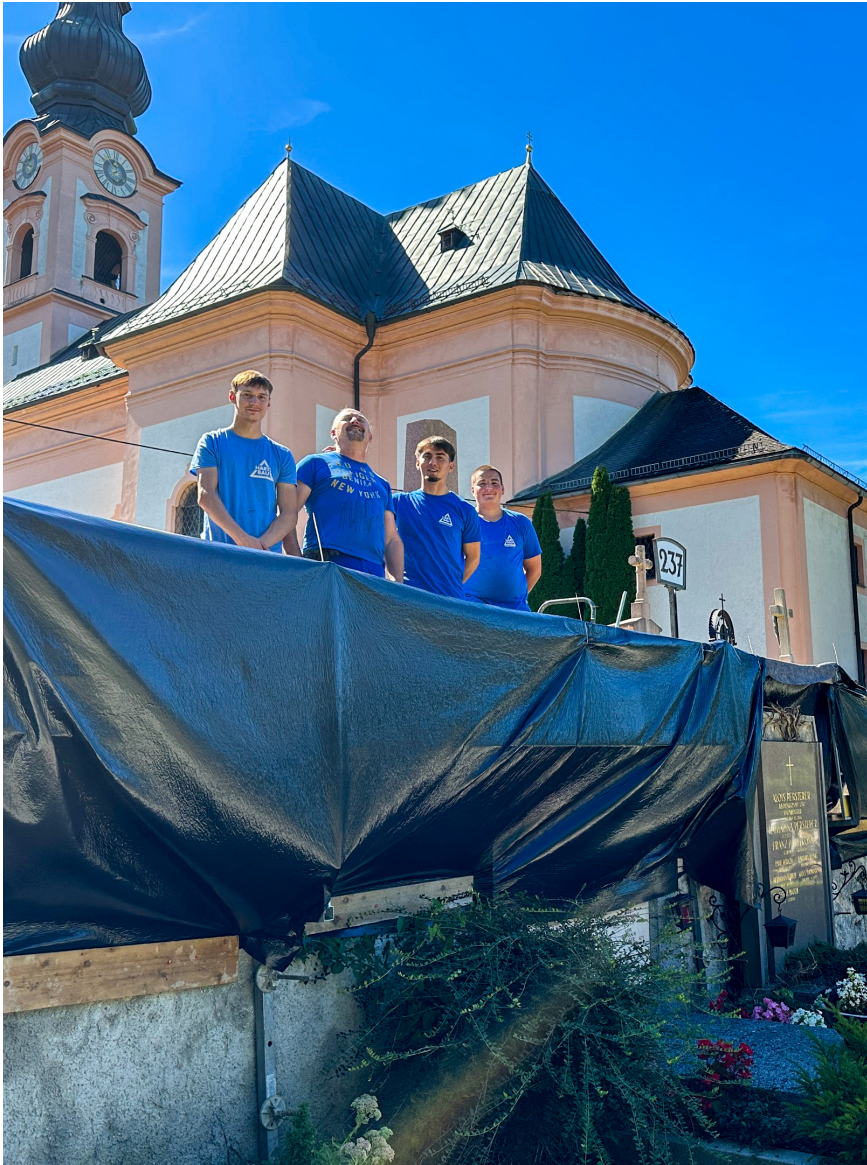
FRIEDHOF GNIGL - SANIERUNG FRIEDHOF SMAUER, SALZBURG, 2025
