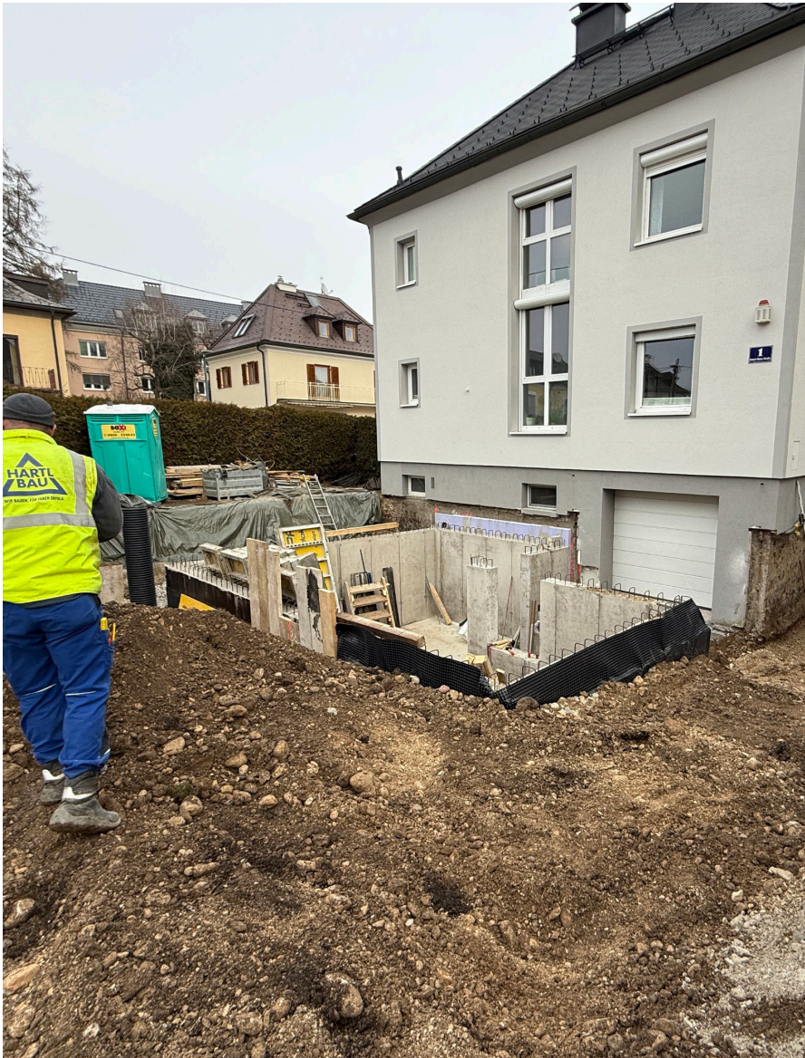
BAULEITER Bmstr. Ing. M. Töplitzer
